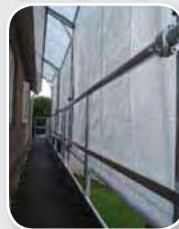
Eenvoudige doorkoppeling zeilen d.m.v. klittenband
