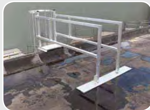
In- en uitloop beveiliging (lengte: 220 cm, hoogte: 110 cm)
