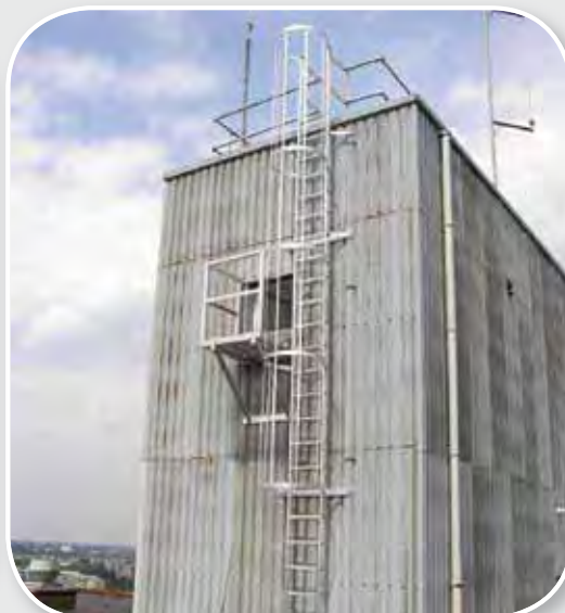
Kooiladder met dakrandbeveiliging
