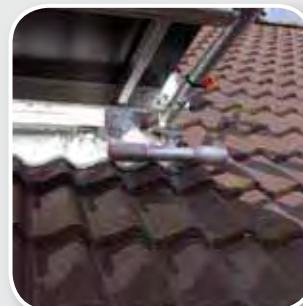
Stempel voorzien van kunststof bescherming
