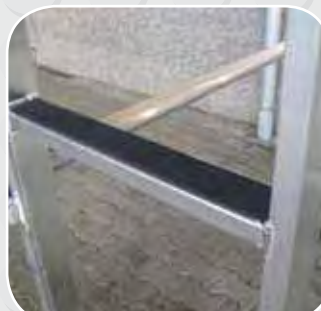
Kar-drager is voorzien van kunststof beschermlaag
