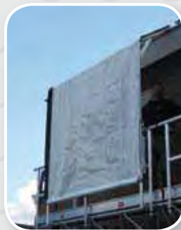
Zeil eenvoudig te monteren door gebruik van horizontaalschoren
