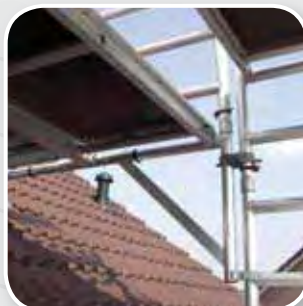
Bevestiging console aan steigerframe
